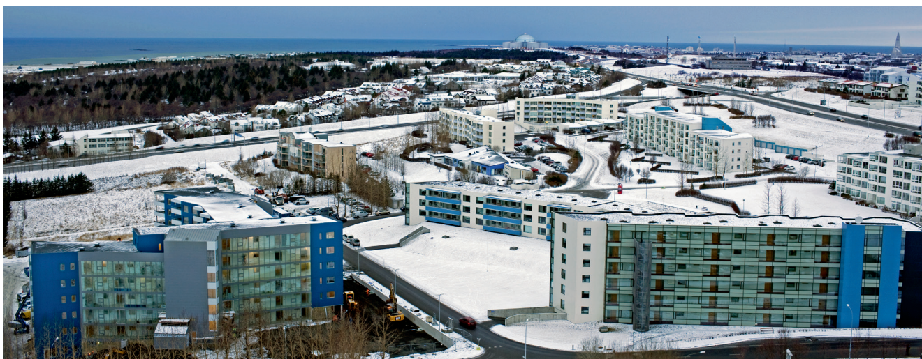
Sléttuvegshverfið 2011 með húsunum 29-31.
