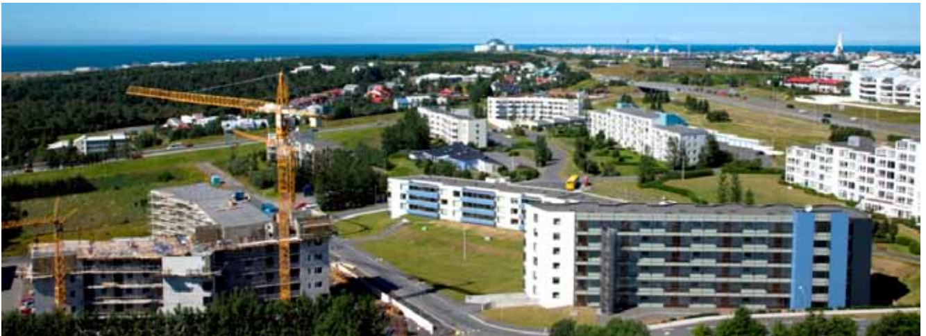
Sléttuvegshverfið, 29-31 í byggingu
